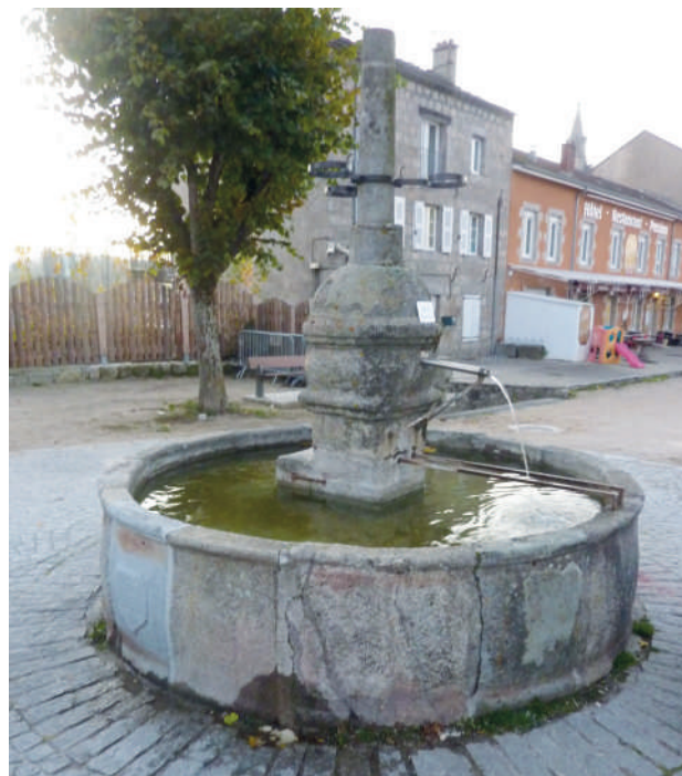
Coût : 5227 €/HT + toute la préparation et remise en état de l'espace pavé réalisées par nos services techniques
